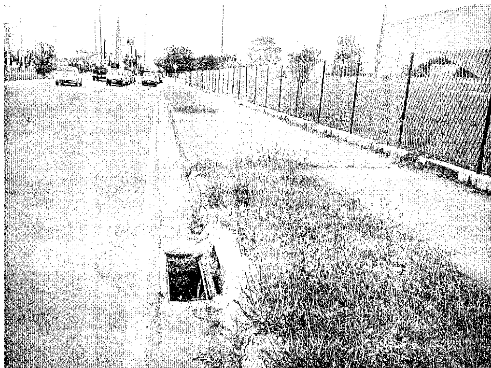
Ausência de peças integrantes aos dispositivos de drenagem
