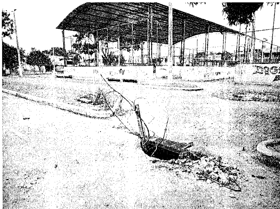
Patologias em dispositivos de drenagem
