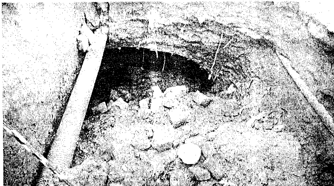
Patologias em dispositivos de drenagem
